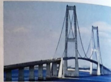
Pont du Grand Belt, Danemark
